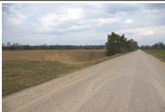
Kopskats no autoceļa V1188 puses
